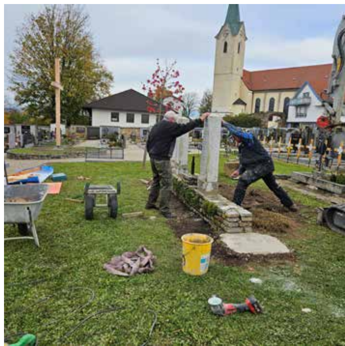
Beim Versetzen der Obelisken
